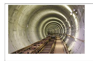
Il est composé de deux tubes parcourus par des trains, et d'un tube de service plus petit. Il est long de 50 kilomètres dont 38 percés sous la mer.
